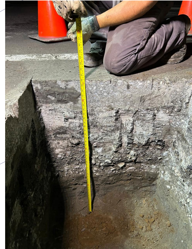
Calicata de exploración y SPT
